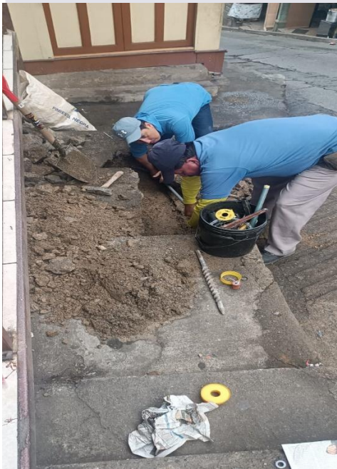
Reparación tubería de distribución de 63mm., en la Calle 10 de Agosto y Colón
