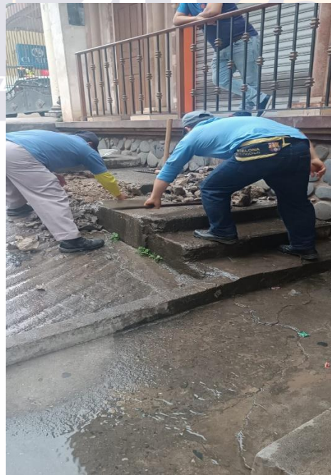
Reparación tubería de distribución de 63mm., en la Calle 10 de Agosto y Colón
