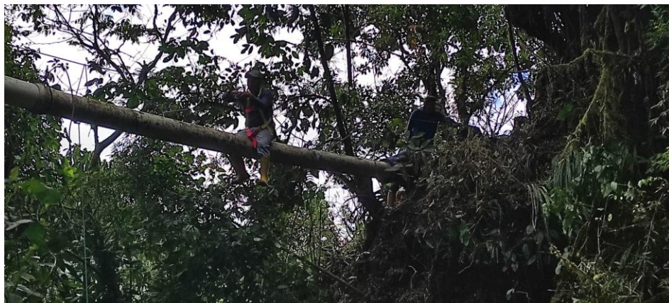
LIMPIEZA DE LA CAPTACIÓN DEL MIRMIR
